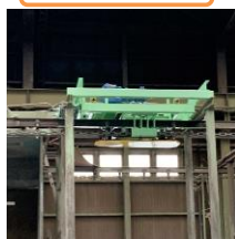
コンバヤ改修工
