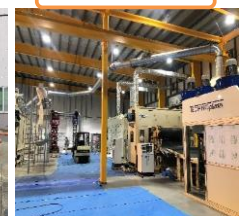
ダクト配管設置
