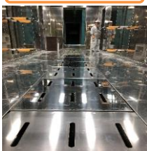
塗装ブース改善工事
